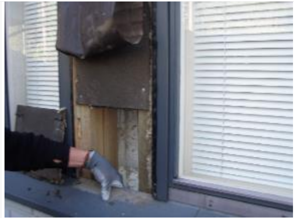
Kuva 65. C-osan ikkunanauhan väliosissa tuulensuojan on bitumoitu puukuitulevy.
