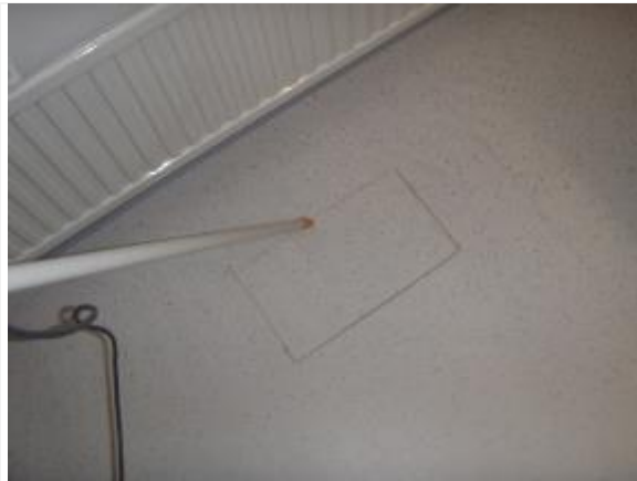
Kuva 88. Ulkoseinästä merkkiaine kulkeutuu B008 lattiassa olevaan tekniikkakoteloon.
