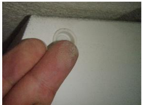
Kuva 98. Samaista betonipölyä esiintyy kattopinnoissa, -valaisimissa sekä tasopinnoilla.
