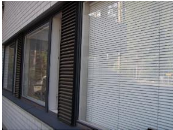
Kuva 64. C-osan ikkunanauhan väliosissa julkisivupinnoitteena on metallisäleikkö.
