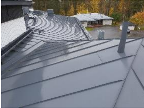
Kuva 71. Vesikate konesaumattu pelti on hyvässä kunnossa.
