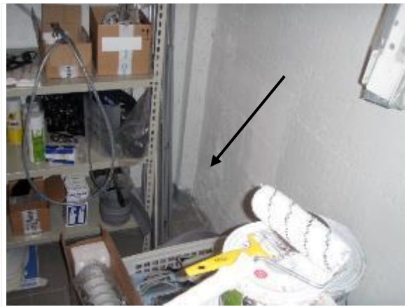
Kuva 101. Varaston A011 perusmuuri korjattu uretaanilla ja maalilla.
