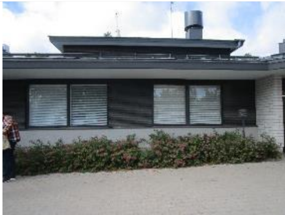
Kuva 62. B-osan ikkunanauhan väliosissa julkisivupinnoitteena on metallisäleikkö.
