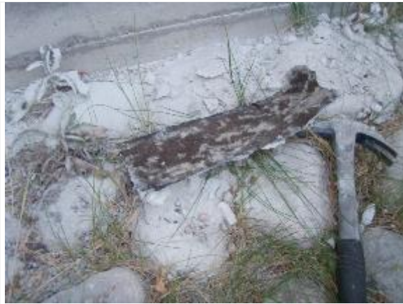
Kuva 53. B-osalla julkisivumuurauksen ja sokkelibetonin välissä on kapillaarikatko.
