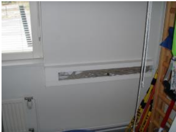
Kuva 83. Sähkökourun sisällä oleva sähköjohtojen läpivienti ulkoseinärakenteeseen, C-osa C008a.
