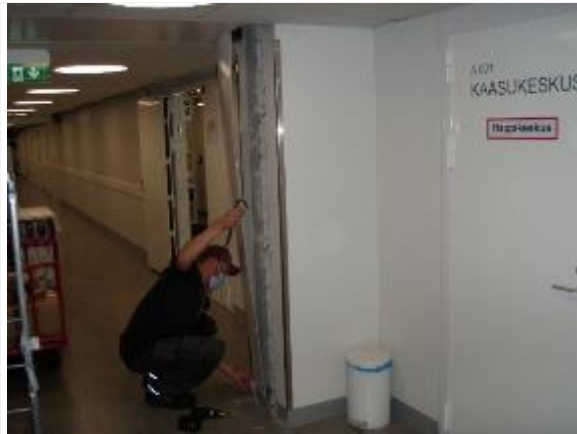
Kuva 30. Huoltokäytävän lounaispäässä vanha ulkoseinärakenne on verhoiltu pellillä.
