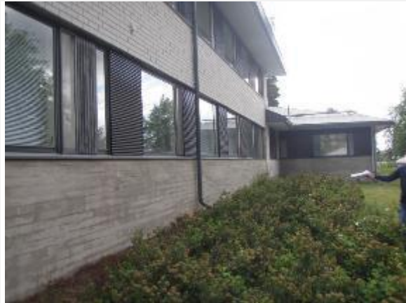
Kuva 3. B-osan lounaan puoleisella seinustalla kasvillisuutta.
