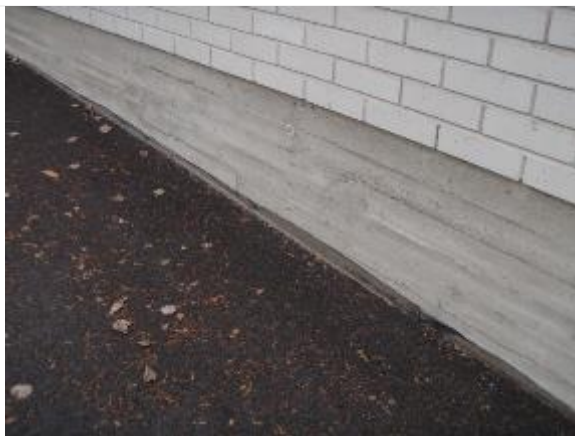
Kuva 16. C-osan sokkelissa kosteuseristys.
