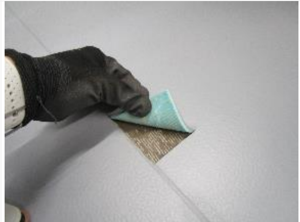
Kuva 27. Lattiapinnoite avauskohdassa VM5 toimisto B028.
