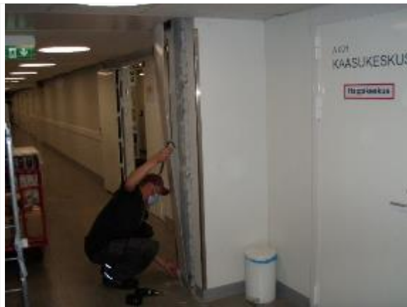
Kuva 40. Huoltokäytävän A003 lounaispäässä vanha ulkoseinärakenne on verhoiltu pellillä.
