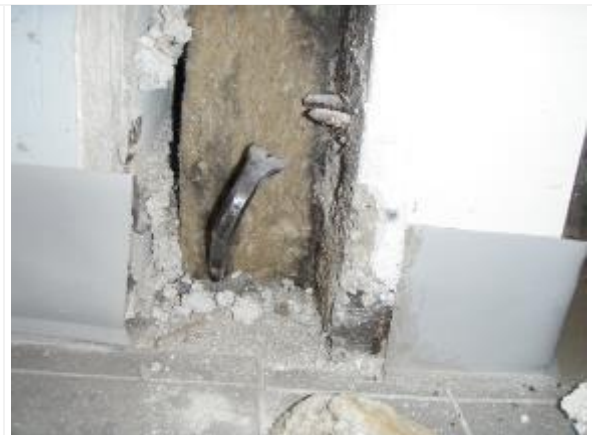
Kuva 41. Vanhan väliseinän eristetila lähteen alapohjarakenteen alalaatan päältä.
