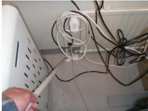
Kuva 77. Tyypillinen vuotokohta laskettaessa merkkiaine ulkoseinärakenteen eristetilaan, välipohjan ja ulkoseinän liitos, B-osa 1krs.
