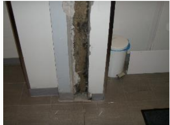
Kuva 31. A- ja B-rakennuksien liitokseen on jätetty vanha ulkoseinärakenne
