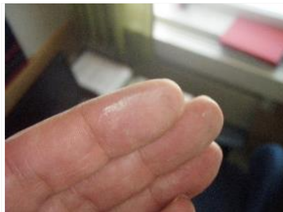
Kuva 97. Tuloilmakanavan pohjalla olevaa hienojakoista betonipölyä.
