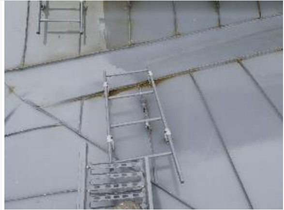
Kuva 72. Vesikate konesaumattu pelti on hyvässä kunnossa.
