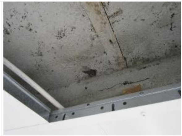
Kuva 102. Käytävän B055 katossa vanhaa korkki-levyä.
