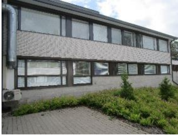
Kuva 60. A-osan ikkunanauhan väliosissa julkisivupinnoitteena on maalattu pelti.
