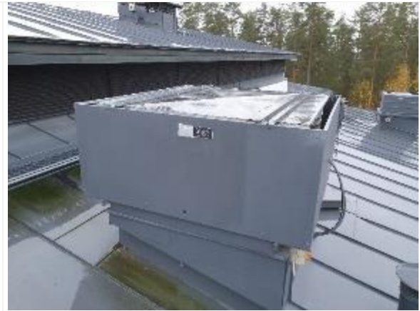
Kuva 100. Kyseisestä IV:n pystyhormista lähtevä runkokanava on liitetty kattolyhdyn toisella puo- lella olevaan poistoilmapuhaltimeen, joka on edelleen käytössä.
