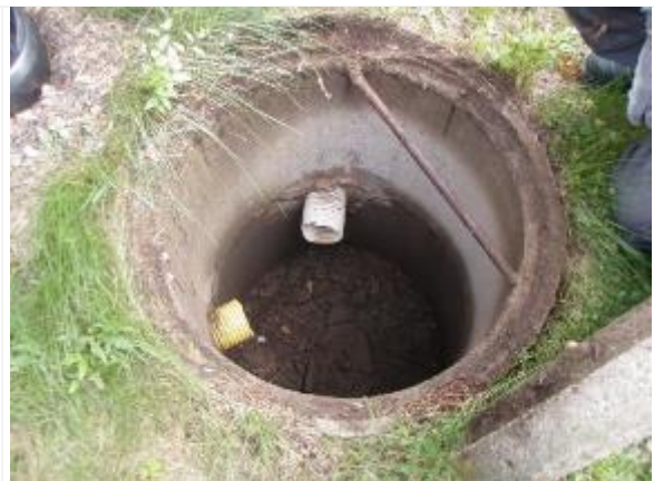
Kuva 6. B-osan salaojan alkuperäinen tarkastuskaivo vuodelta 1985.
